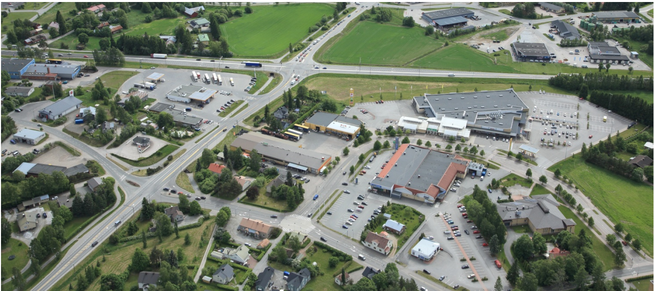
Viistokuva pohjoisesta päin kohti valtatie ja kantatien risteystä. Kauppakadun varren alue oikealla, vasemmalla kantatien itäpuolista kaavamuutosaluetta. (Kuva vuodelta 2017: Laitilan kaupunki).
